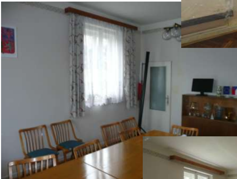
Stav interiéru před opravami.
