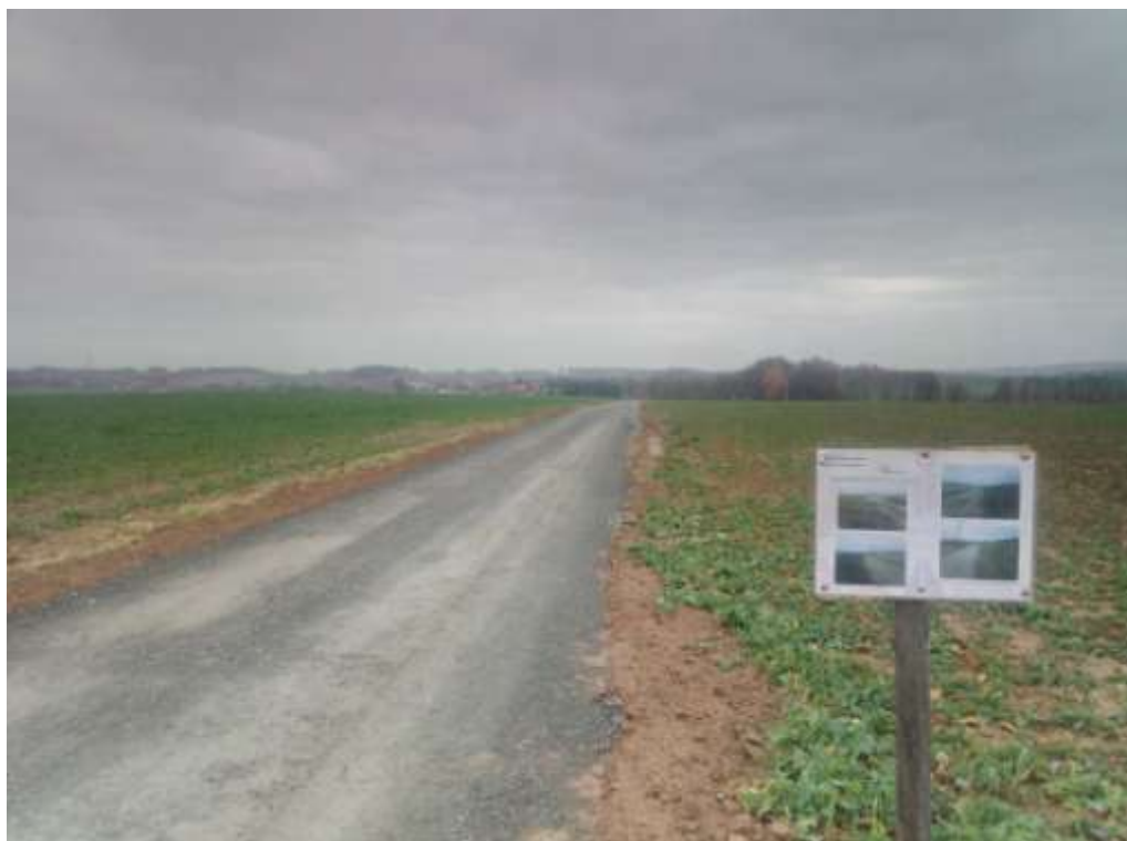
Dokončená 3. etapa výstavby komunikace – pohled z výhybny realizované při 2. etapě výstavby v roce 2017.
