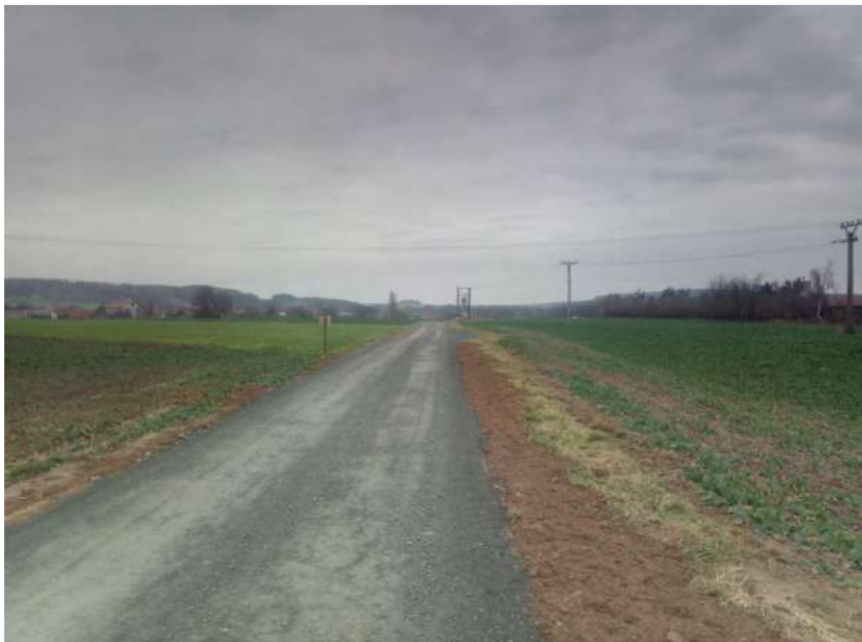
Dokončená 3. etapa výstavby komunikace ve směru od Budětska do Ochoze.
