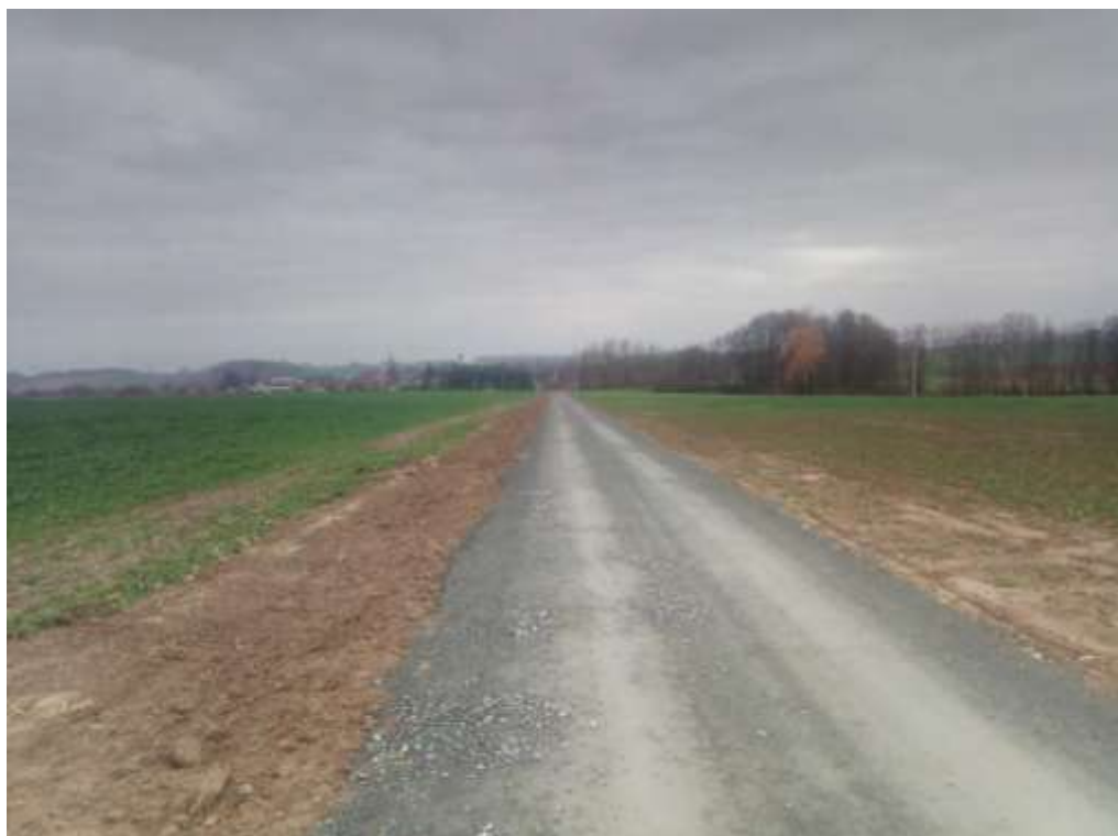
Dokončená 3. etapa výstavby komunikace – střední část.
