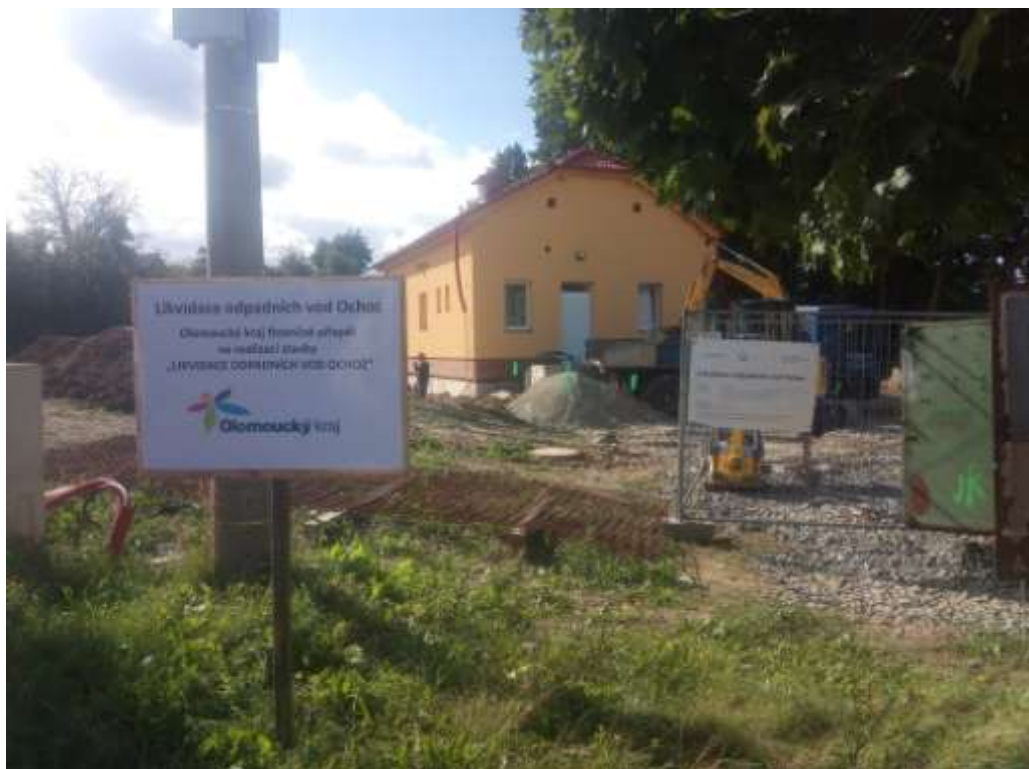
Čistírna odpadních vod ve výstavbě
