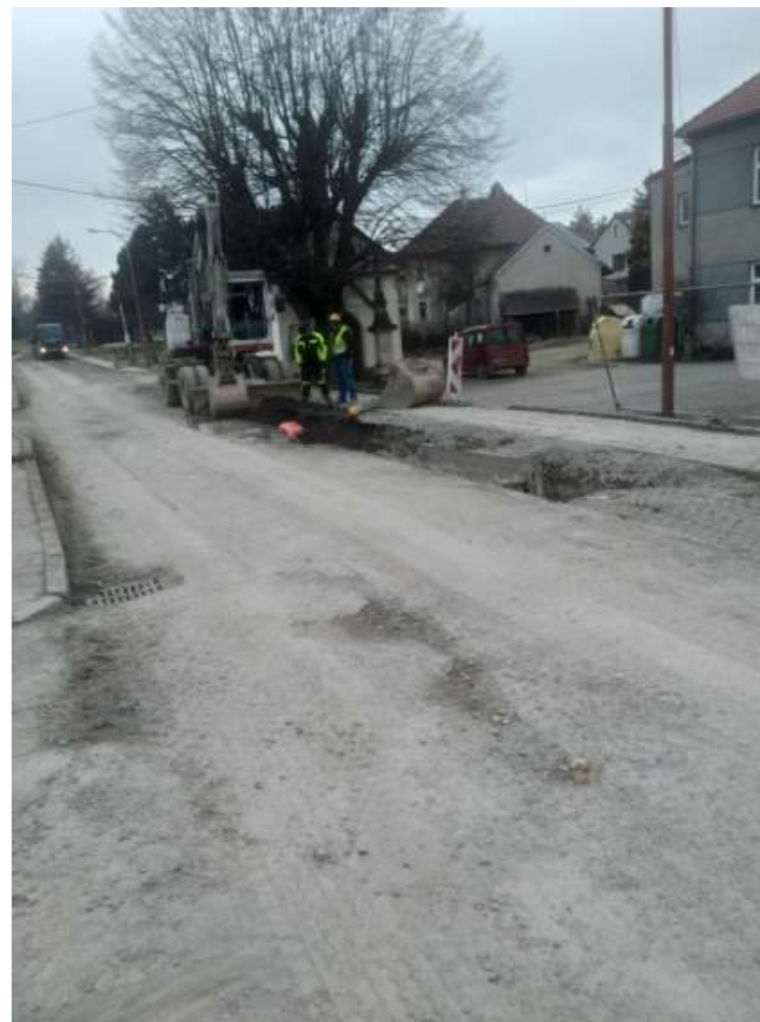
Výkopové práce na návsi
